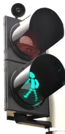
Proponowany sposób montażu głośnika tubowego.
